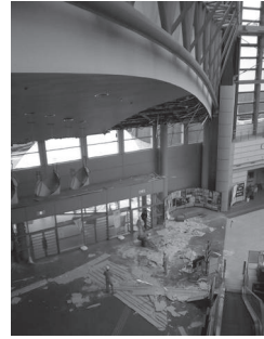
アトリウム吊天井落下物
